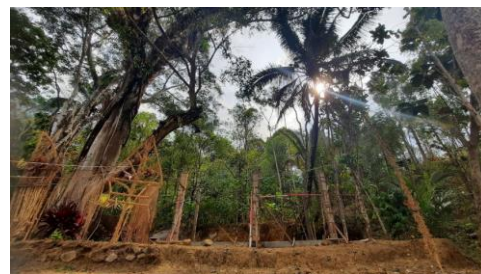
Gambar 9. Proses Pembangunan Pendopo Petilasan
