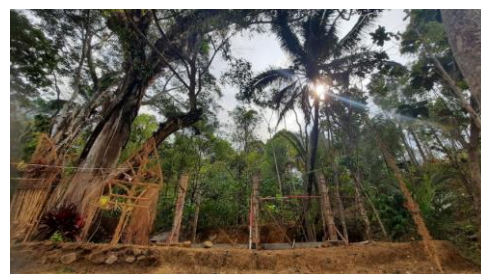
Gambar 9. Proses Pembangunan Pendopo Petilasan
