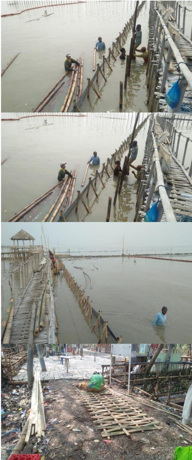
Gambar 1. Proses pembuatan penahan sampah hybrid dari bambu
