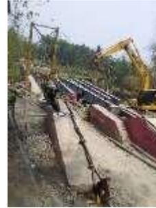
**Gambar 11. Pengangkatan girder menggunakan excavator**
