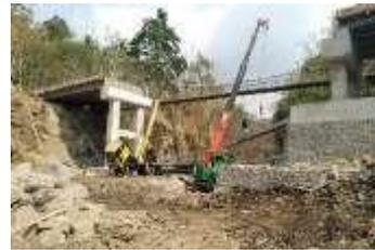
**Gambar 12. Pengangkatan girder menggunakan crane**
