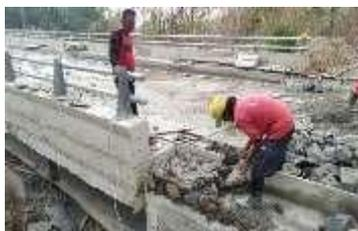
**Gambar 15. Proses pemasangan sandaran jembatan**
