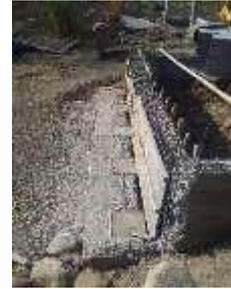
**Gambar 9. Pembuatan abutment**
