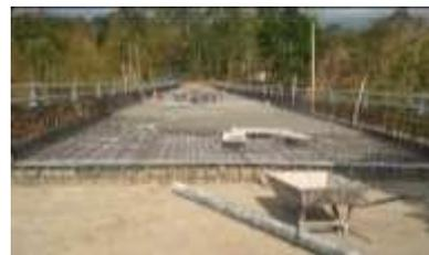
**Gambar 14. Proses pengecoran pada pelat lantai jembatan**
