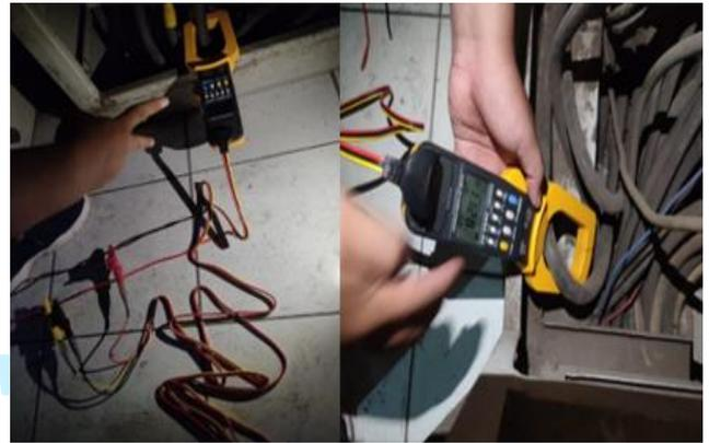
Gambar 6. Cara pengukuran arus pada panel MDP fasa S
